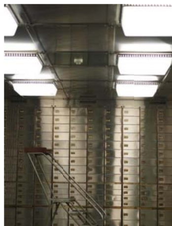
Figura 03.48 - Detalhes dos Cofres de Alugues, na cave. Fotografia do autor
