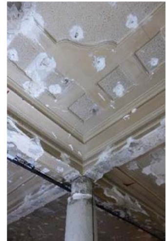
Figura 03.45 - Fragmentos do revestimento dos tectos do piso térreo, caracterizados pela utilização de acabamento estucado e bordadura com sanca. Fotografia do autor.
